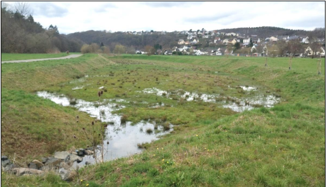
Abb. 13: Regenrückhaltebecken südwestlich d. Plangebiets 2023
